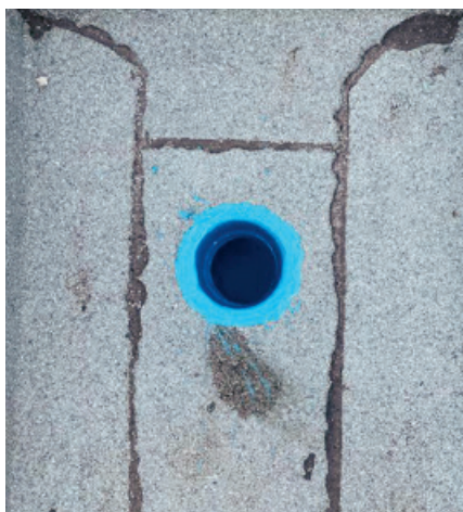
Rohrleitung nach der Sanierung mittels Spraypoxy-Verfahren
