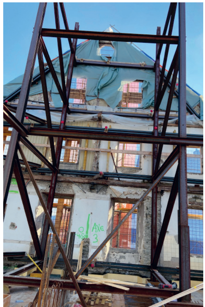
Bestehende Fassade mit Giebel, gestützt von Stahlgerüst
