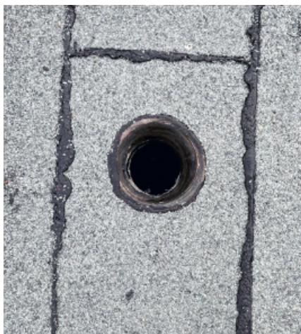
Rohrleitung vor der Sanierung
