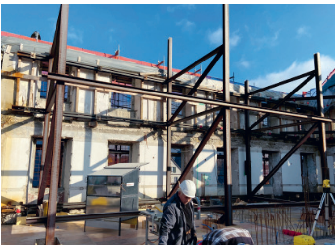
Bestehende Mauern des historischen Posthorns mit Stahlgerüst
