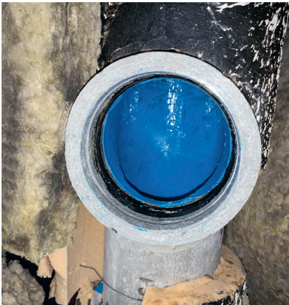
Mit Epoxidharz sanierte hausinterne Abwasserleitung
